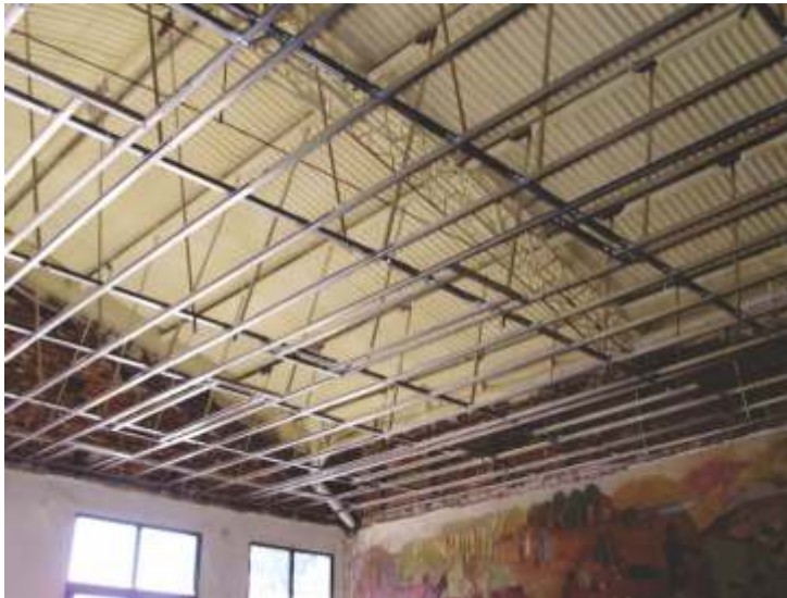
Estado de las obras de refacción, en junio de 2.008 – Salón Mayor
