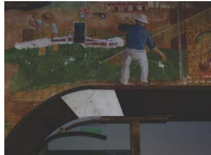
Apuntalamiento de la arcada de acceso al Salón Mayor – Año 2008
